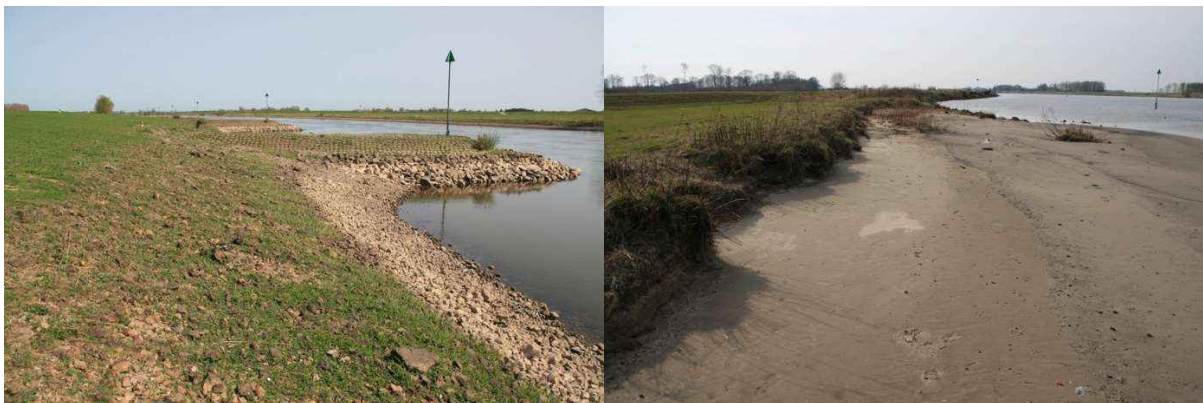
Figuur 3.5. De oevers van de IJssel werden in de jaren '80 van de vorige eeuw grotendeels vastgelegd om erosie door scheepvaartgolven te voorkomen. Recent zijn enkele oevers in het kader van de KRW weer ontsteend (de foto rechts is van een traject nabij Olst, stroomafwaarts van HBFO).
