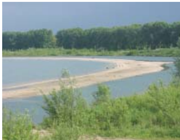
In Asselt Zuidoost is in het kader van de herinrichting een lage zanddam opgespoten, waarachter een ondiepe lagune is ontstaan.
