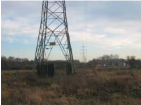
Hoogspanningsleiding met op de achtergrond de RWZI Schinveld
