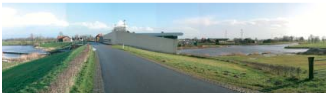
Gemalen blokkeren de verbindingen tussen de beken en de IJssel, van natuurlijke mondingen is geen sprake meer. De ecologische verbinding kan echter ten dele worden hersteld. VAN BOVEN NAAR ONDER: gemaal Voorster Beek, gemaal Toevoerkanaal (bij Terwolde), gemaal Baakse Beek en gemaal de Veluwe (bij Hattem).
